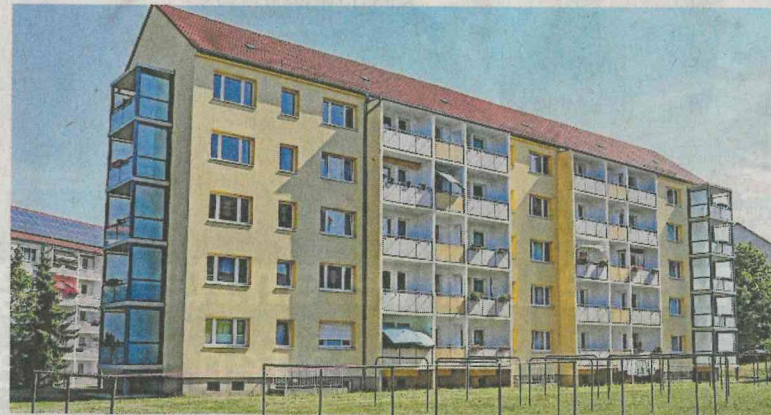
Die Wohnungen im Herderweg 14 bis 18 in Werdau haben jetzt alle Balkone. An der Pestalozzistraße 76 bis 80 wird derzeit noch gebaut. FOTO: THOMAS MICHEL
