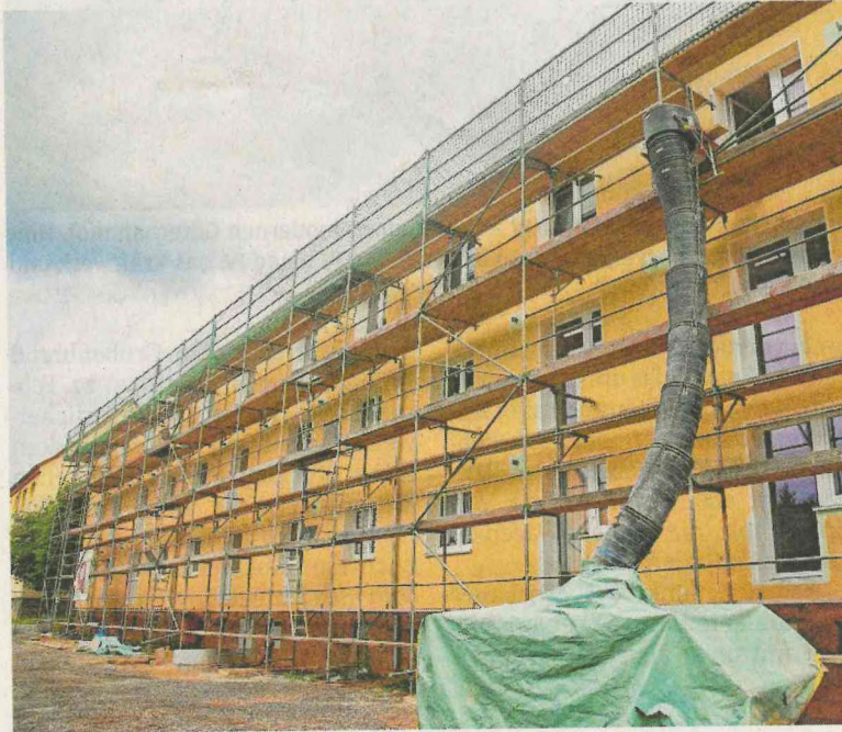
Der Großvermieter investiert weiter und stattet in diesem Jahr unter anderem den Wohnblock Holzstraße 25-29 mit Balkonen aus. FOTO: THOMAS MICHEL
