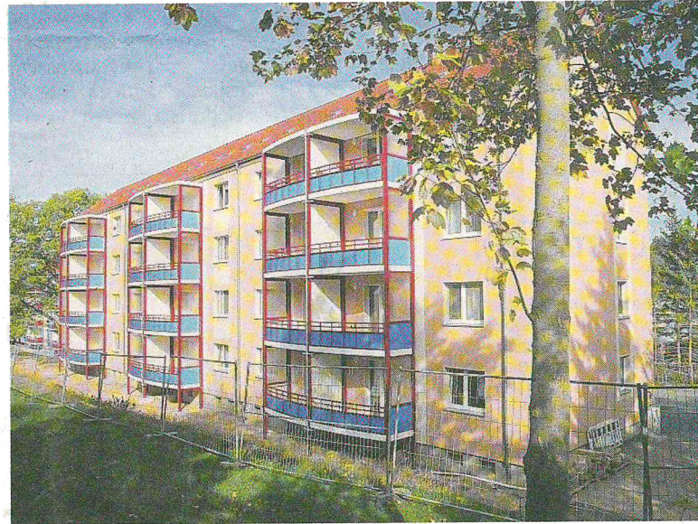
Das Wohnhaus Ziegelstraße 64 bis 68 in Werdau hat Balkone erhalten. Bis Ende Oktober soll das Projekt abgeschlossen sein.
