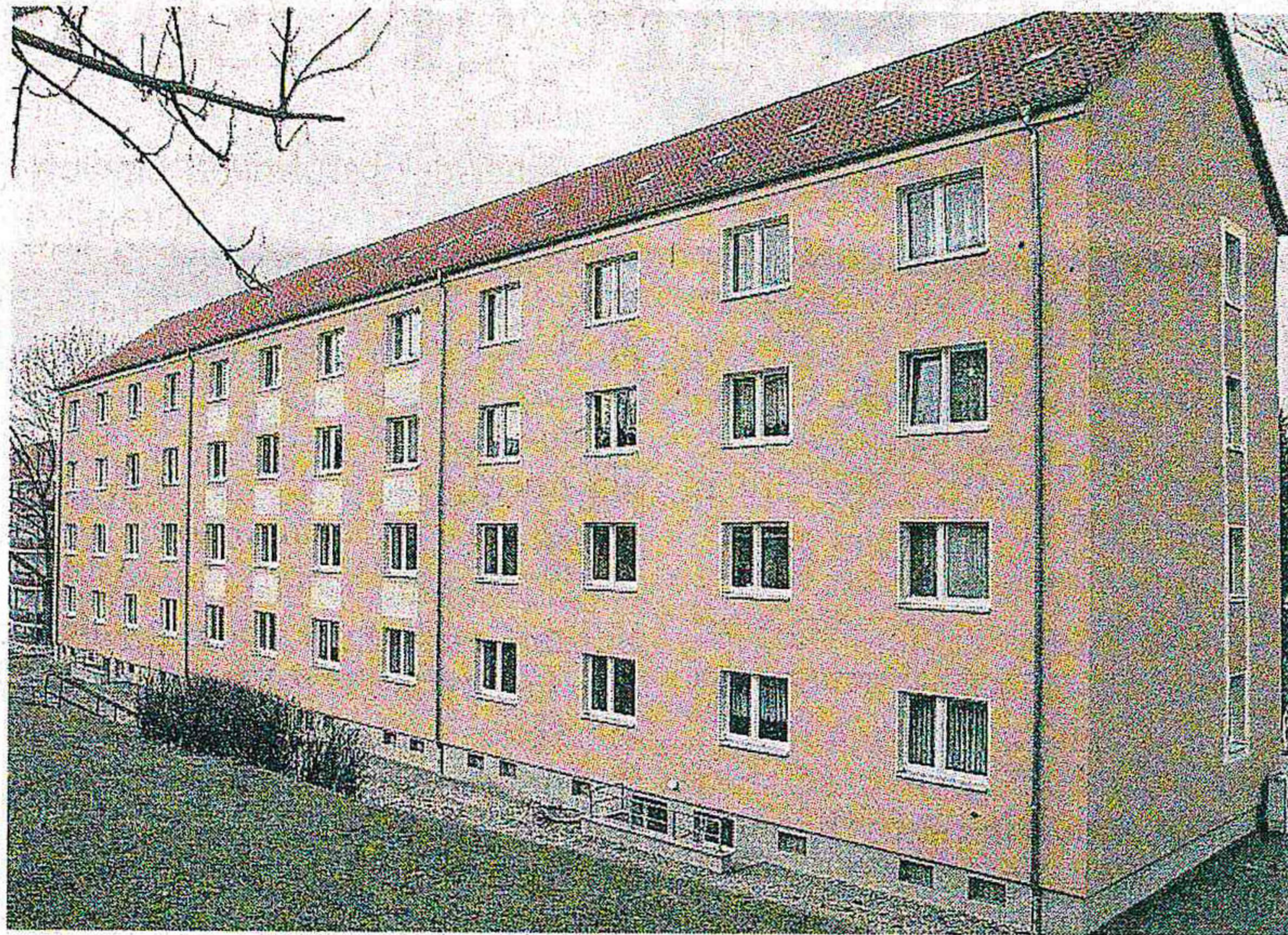
Das Haus Ziegelstraße 64 bis 68 in Werdau-Ost bekommt in diesem Jahr Balkons an die Südseite.
